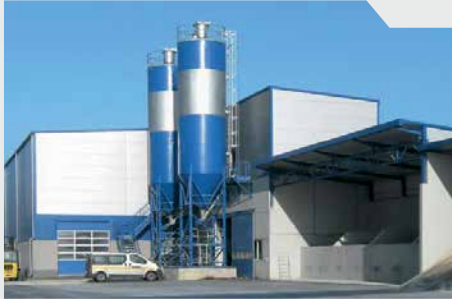
Centrale à béton
